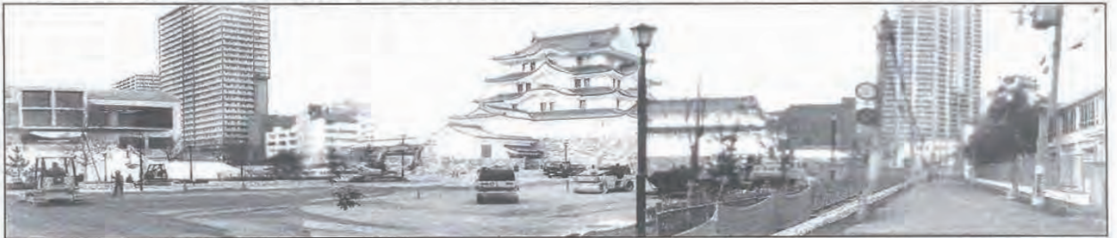
写真：尼崎城址公園整備中の風景（2019年3月撮影）
